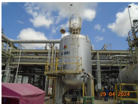
ภาพที่ 2.1-28 ถังดักของเหลว (Knock out Drum)
