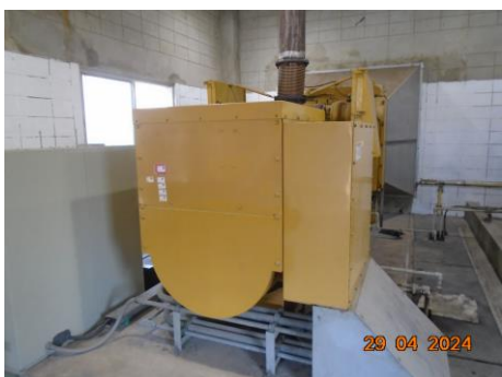
ภาพที่ 2.1-33 Diesel Generator
