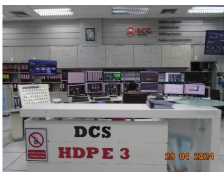
ภาพที่ 2.1-32 Distributed Control System (DCS)
