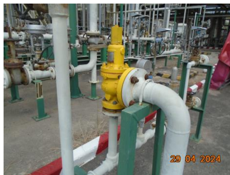
ภาพที่ 2.1-6 วาล์วนิรภัย (Safety Relief Valve)
