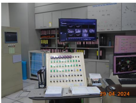
ภาพที่ 2.1-34 Interlock System และ Alarm Annunciator
